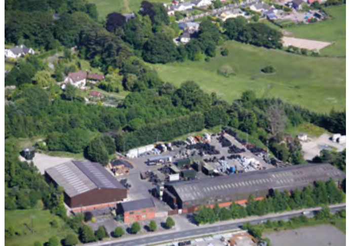
Birr -Irlanda , il nostro nuovo sito di produzione di dispositivi in materiale composito e in acciaio zincato o inossidabile. Sistemi certificati ISO 9001, ISO 14001, OHSAS 18001 per la gestione della qualità, dell'ambiente, dell'igiene e della sicurezza.
